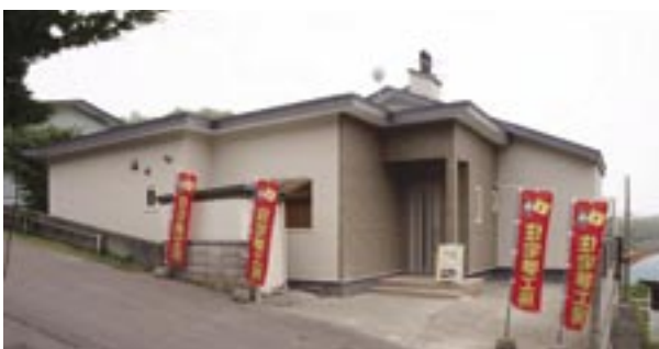
今月上旬に室蘭市内で公開した平屋建ての『新築こえるくん』。屋根にパッシブ換気の排気筒が見える
